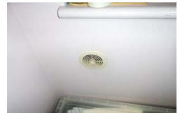
居室の外壁に設けられた給気口の例
