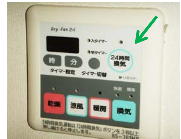
「24時間換気機能」ボタンがついた浴室換気乾燥機リモコンの例
