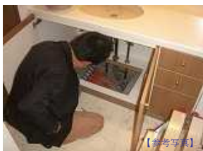
洗面台下の点検口
