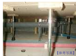
点検口から床下をカメラで撮影
